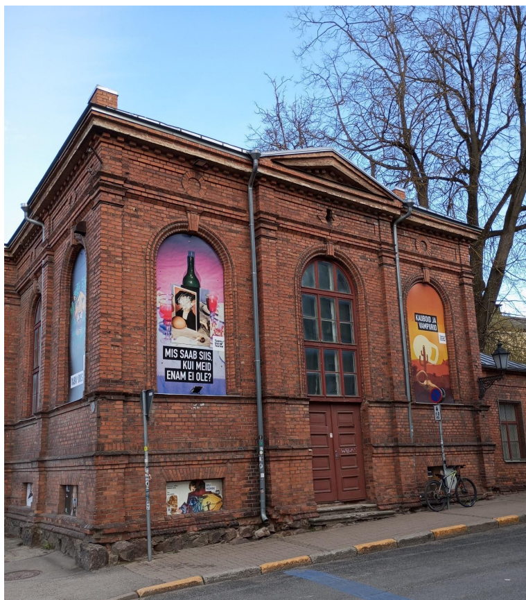
Obrázek 9 Budova TARTU UUS TEATER
